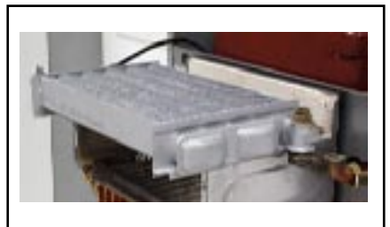
Rys.: Demontaż wymiennika ciepła wody grzewczej
