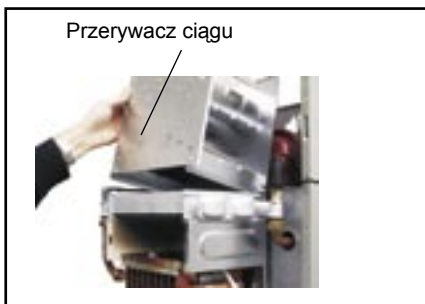
Rys.: Przerywacz ciągu
